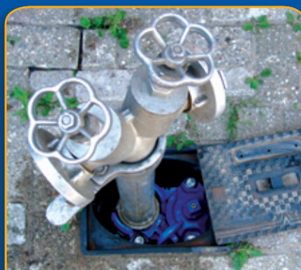
ondergrondse brandkraan
